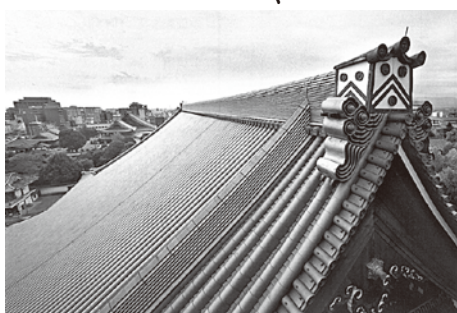
完成した御影堂の大屋根
