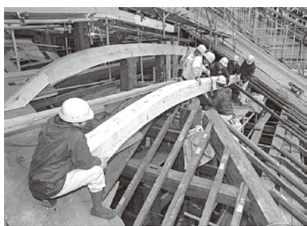
端母屋桁（新桁）取り替え作業
